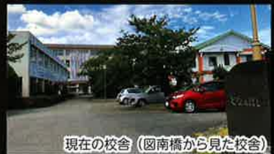
現在の校舎 (図南橋から見た校舎)
